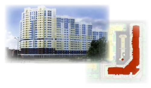
ГК «НДМ» разработан эскизный проект жилого шестисекционного дома со встроеннопристроенными нежилыми помещениями переменной этажности (12-20 эт). На основании согласованного эскизного проекта разработан полный перечень проектной документации.
